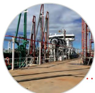
Hemos desarrollado un sistema pionero de carga y descarga de productos petroquímicos en el Puerto de Huelva. Se trata de un juego de mangueras que permite simultanear la carga de diferentes productos, ofreciendo además un mayor caudal de bombeo. De esta forma, los tiempos de carga y descarga se reducen entre un 50% y un 60%, con un ahorro aproximado de 2.160 horas de atraque al año y un 20 por ciento menos de ocupación de las instalaciones.
